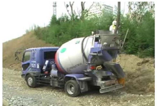
先送りモルタルの回収（廃棄）
