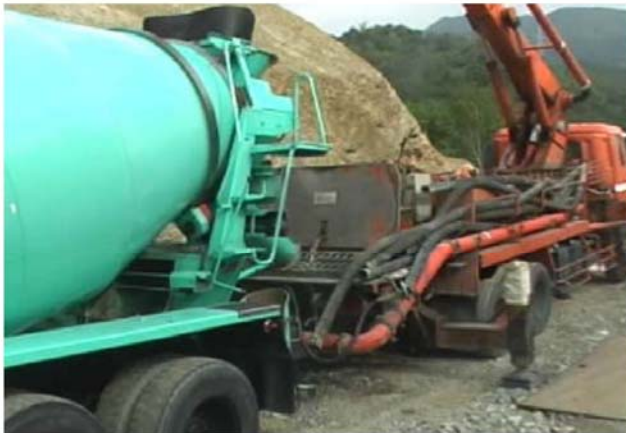
先送りモルタルの圧送
