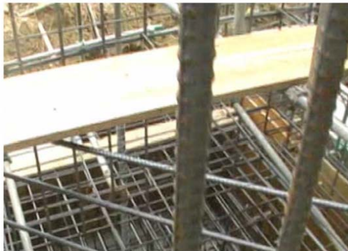
歩み板等を敷き渡し、直接鉄筋の上を歩かない
