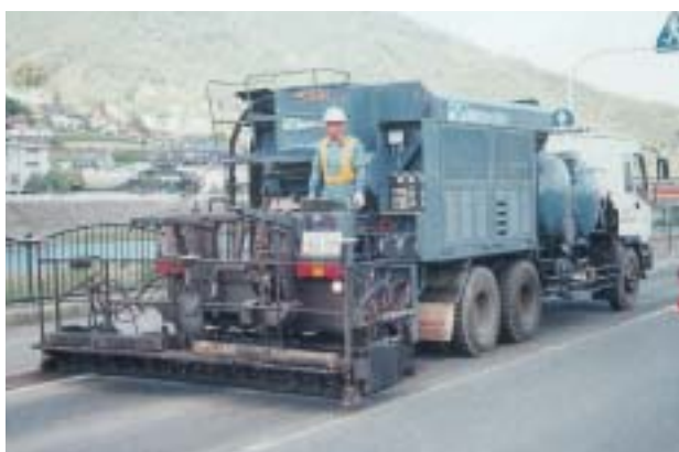
写真-1: マイクロサーフェッシングペーパーによる施工状況
