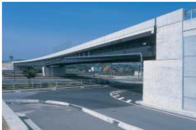
●一般県道 山口阿知須宇部線 平成大橋(2径間連続鋼床版箱桁橋)
