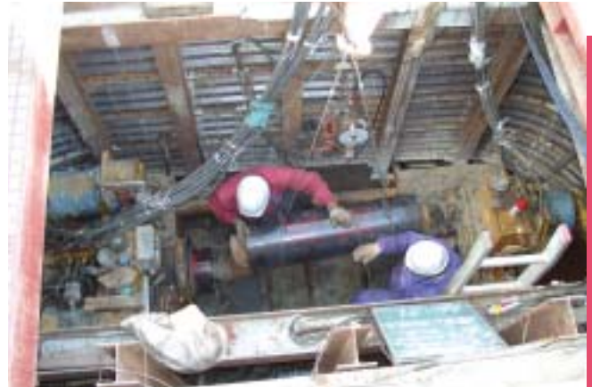
●橘町公共下水道事業 小口径推進工法鋼製さや管方式
