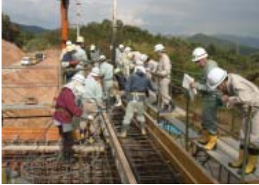
●コンクリート打設を間近で見学
