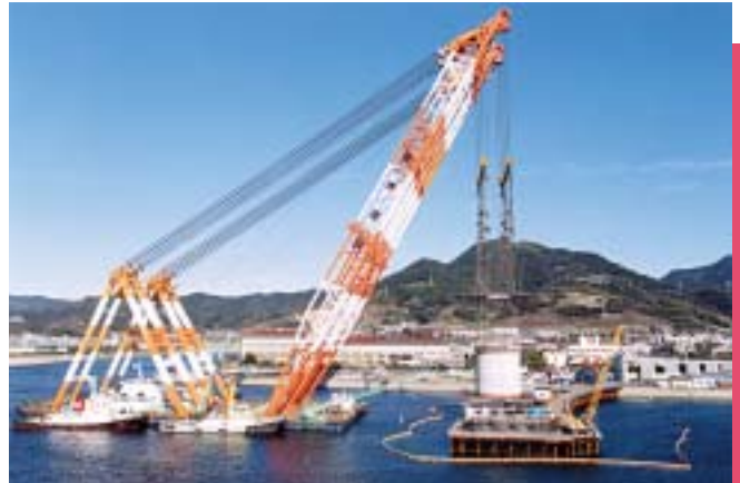
●徳山下松港 臨港道路 新南陽大橋(ケーソン据付)
