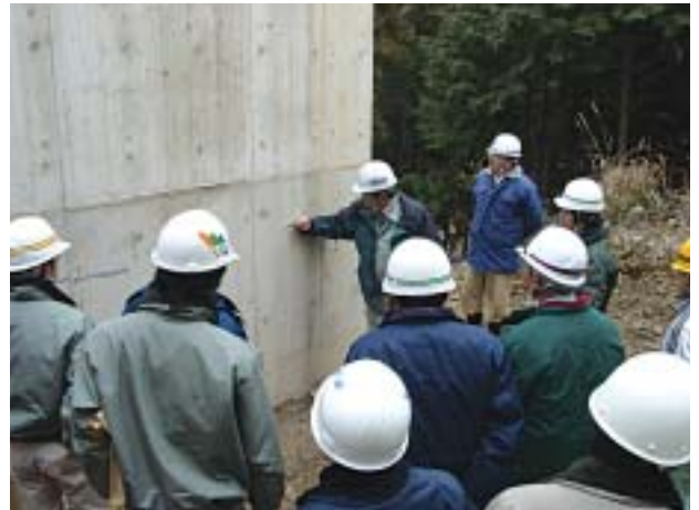
コンクリート表面状況の説明
