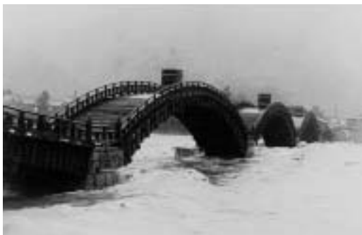
昭和25年9月14日のキジャ台風により、流出する寸前の錦帯橋。橋の流出を防ぐため、橋上に置かれた樽には水が満載されていた。（岩国市 錦帯橋建設事務所提供）
