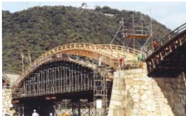
修復中の錦帯橋
