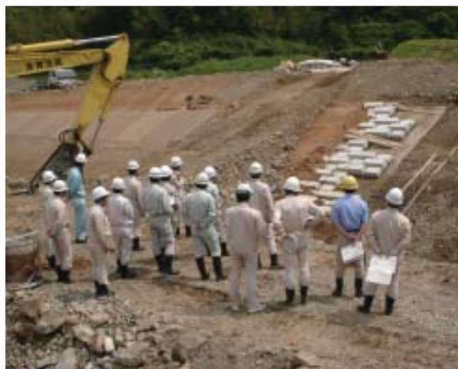
護岸工(河川工事)現場
