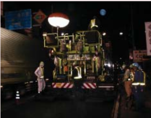
舗装施工状況
