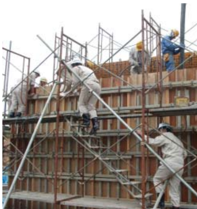
8号橋下部工現場
