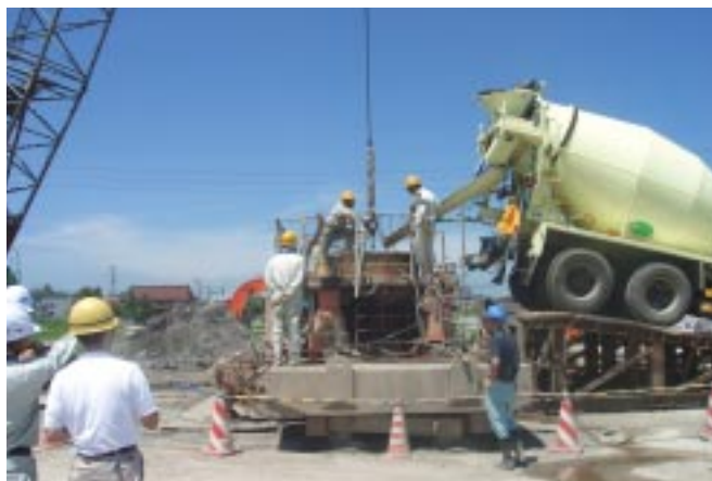
▲場所打杭のコンクリート打設
