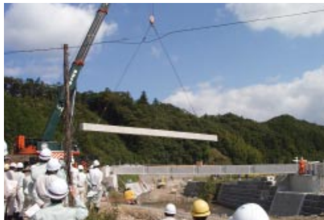
▲クレーン車によるPC桁架設
