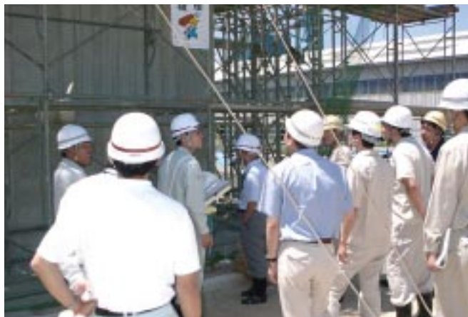
▲橋脚の型枠支保の施工の説明状況
