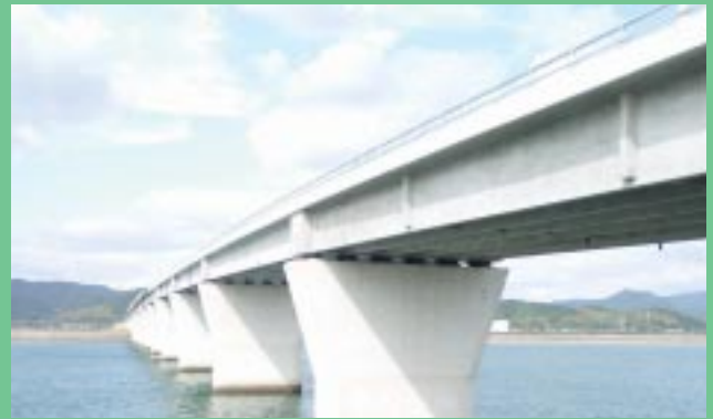
▲主要県道防府環状線(佐波川大橋)
