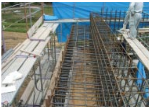
▲写真-5 橋台たて壁、翼壁配筋状況
