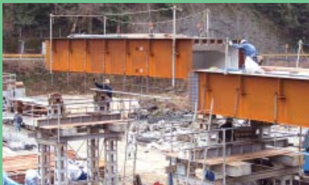
▲集落道川向線橋梁開設工事(美川町)
