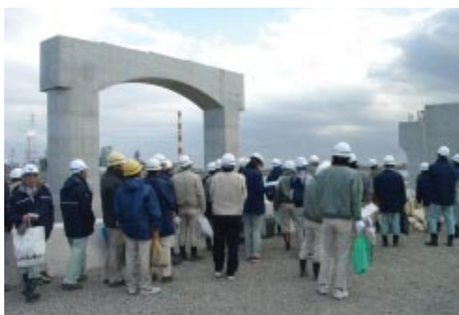
▲宇部湾岸線 新厚東川橋
