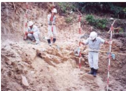
▲写真-1 橋台掘削工の岩盤判定
