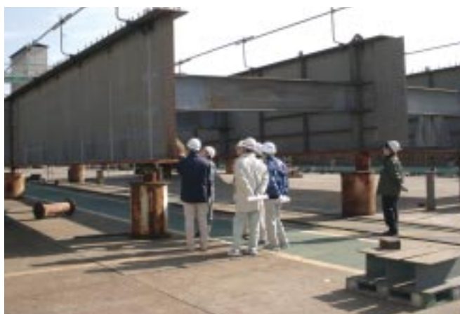
▲鋼橋 工場製作
