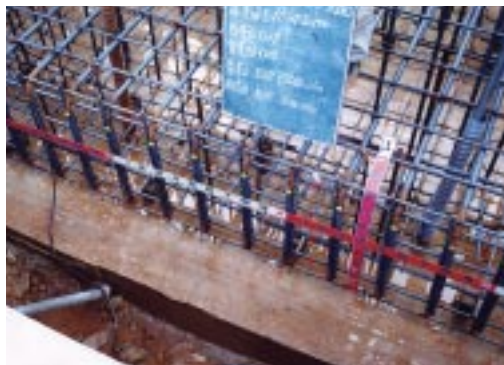
▲写真-3 橋台フーチングの配筋状況
