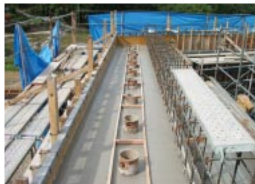
▲写真-6 橋台コンクリート最終打設後
