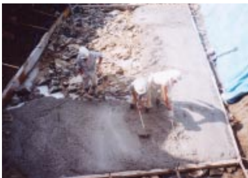
▲写真-2 橋台均しコンクリート打設状況
