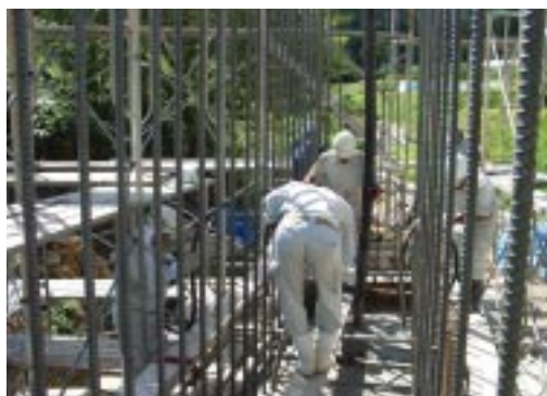
▲写真-4 橋台たて壁コンクリート打設状況
