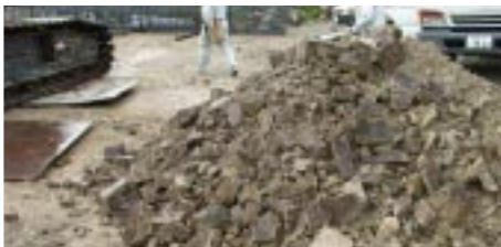
写真-1 掘削土砂(軟岩)の確認
