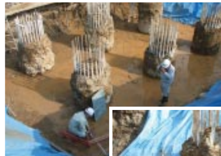
写真-4 場所打ち杭の打設状況 (杭頭処理前)
