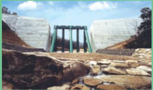
▲八幡谷溪流通常砂防工事(透過型砂防堰堤)
