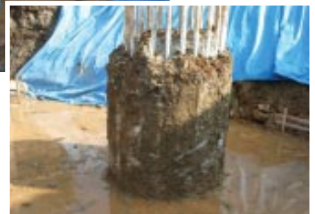
写真-4 場所打ち杭の打設状況 (杭頭処理前)
