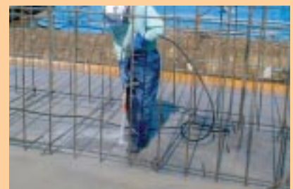
高圧水によるレイタンス除去作業
