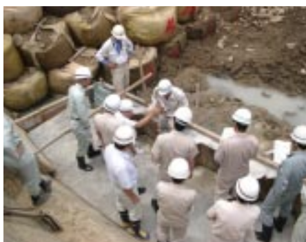
▲鋼矢板打込み完了に伴う段階確認(横曽根川)
