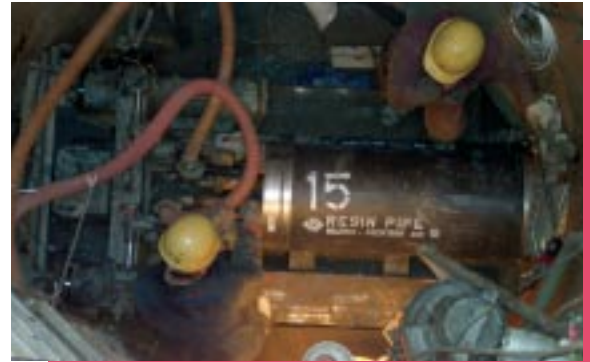
●宇宇町港町地区 汚水管渠布設工事(宇宇町港町)
