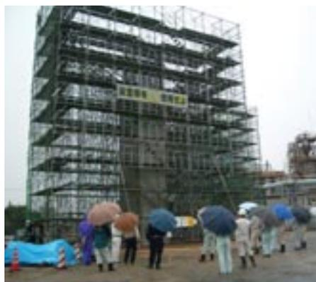
▲橋脚の型枠支保・足場工(手すり先行型)
