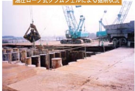
油圧ロープ式クラムシェルによる掘削状況
