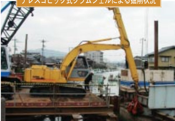
テレスコピック式クラムシェルによる掘削状況
