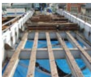
木床版撤去状況
