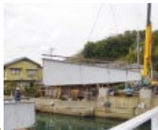
主桁撤去作業状況
