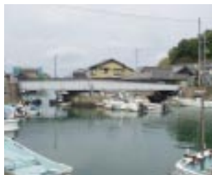
平和橋現況(側面)
