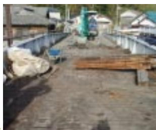
舗装版はぎ取り作業状況
