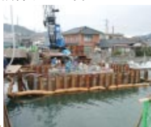
仮締切り土留め設置状況
