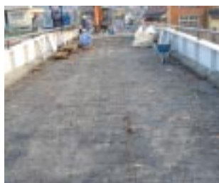
舗装版はぎ取り完了
