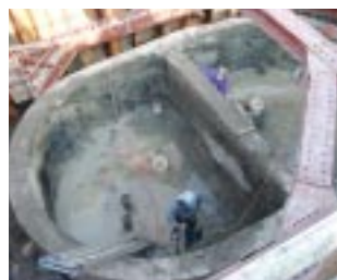
ケーソン中詰土砂搬出状況
