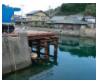
撤去作業完了
