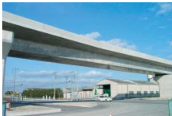
●都市計画街路宇部湾岸線(厚南高架橋(仮称))
