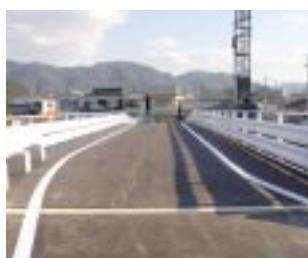
仮橋設置完了
