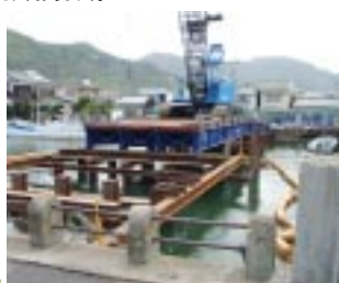
仮橋設置作業状況
