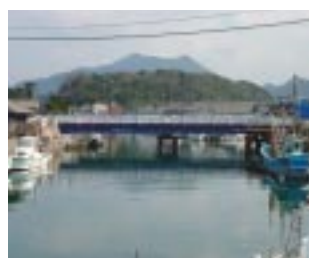
撤去作業完了
