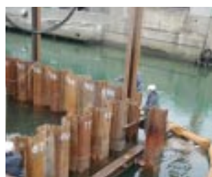
鋼矢板閉合作業状況
