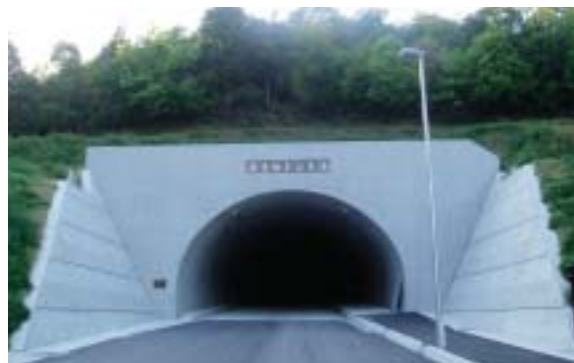
●一般県道藤生停車場錦帯橋線(麻生田トンネル)
