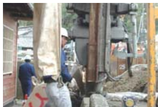
▲パイルオーガ先端状況
