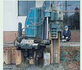
▲鋼矢板の圧入作業状況
