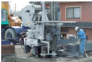
▲初期圧入状況(反力架台有り)
