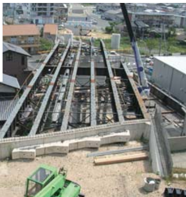
▲(主)萩川上線 主桁架設(トラッククレーン)
