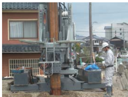
▲鋼矢板打設(硬質地盤用)
