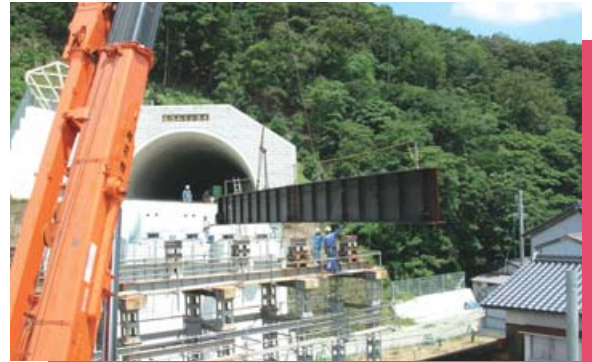
●主要県道萩川上線 主桁トラッククレーン架設
