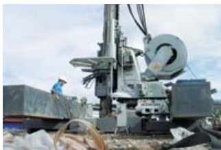
▲反力架台セット状況
