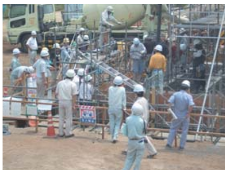
▲フーチングコンクリート打設
