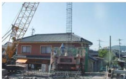
掘削はケーシング回転掘削工法による。杭径φ1.0m、杭長L=26.0m。
