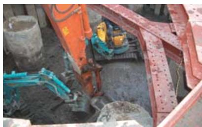
仮締切内(WL-1.88まで)の掘削状況。地盤変化、湧水等に留意し慎重に施工。
