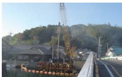
パイプロハンマによるH鋼杭の打込。
