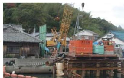
ヤードが狭小なためオールケーシング掘削機及びクレーンを作業構台上に配置。
