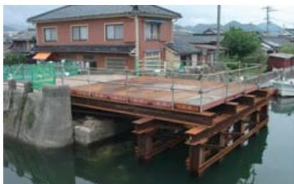
平成17年10月、A1側を最初に着工。作業構台は前年度より設置済。
