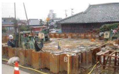
二重管ストレーナー工法(单相式)による掘削時の盤ぶくれ防止対策を実施。
