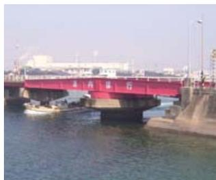
※塩の積出港や商船の停泊地として発展した問屋口と向島を結ぶ旋回橋。橋中央部に回転鋼橋が設けられている。
