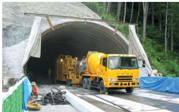
●国道434号 大和田トンネル 吹付コンクリート施工中
