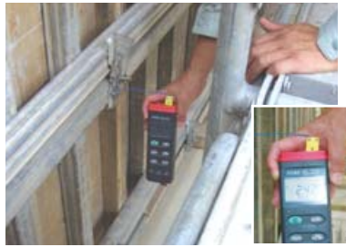
温度計測器設置(打設前温度)
