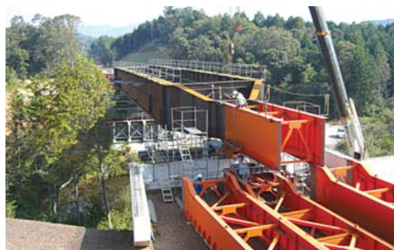
●一般国道490号 板橋ため池橋(仮称)(送出し工法)
