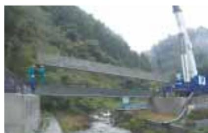
写真2：トラッククレーン桁架設状況
