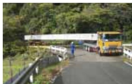
写真1：ポールトレーラーによる桁搬入
