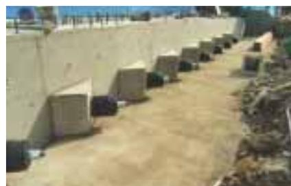
写真4：落橋防止構造
