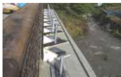
写真3：支承および変位制限構造
