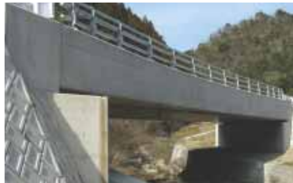
●萩市道立野福川線 飛石橋
