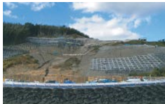
一般県道梶島榎ヶ浜停車場線 災害復旧工事
