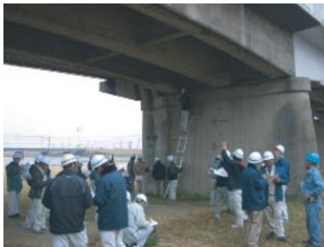
写真-1:現場研修(コンクリート橋) 各部材ごとに損傷状況をシートに記入している状況
