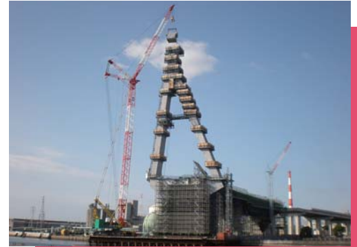
●宇部湾岸線 栄川大橋（仮称）主塔部架設
