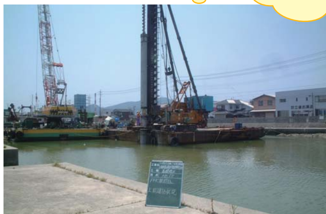
PHC 杭打込状況
