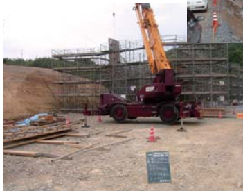
ラフテレーンクレーン：山口宇部線
