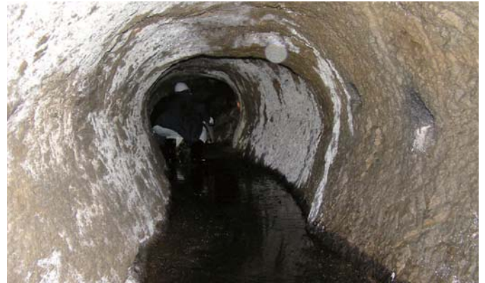
トンネルの坑内
