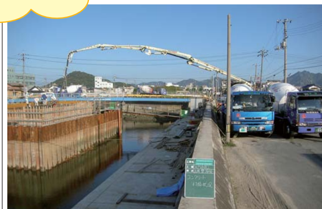
コンクリート打設状況
