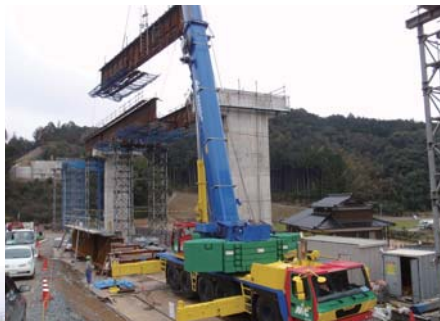
トラッククレーン：山口宇部線
