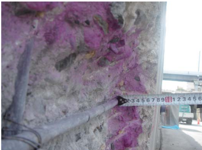
中性化測定状況
