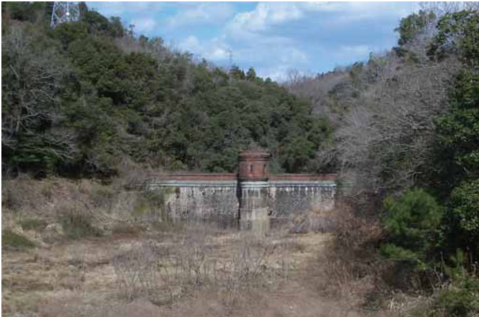
現在の小郡上水道貯水池
