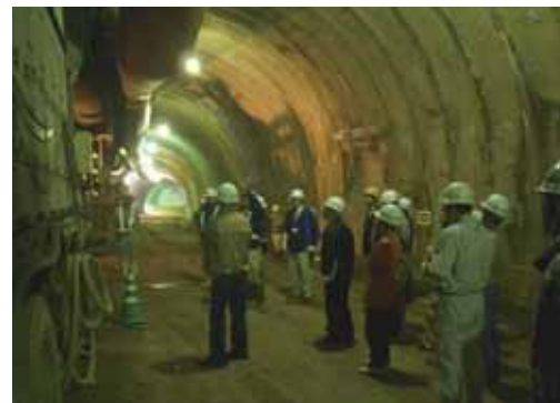
●一般国道434号 須川第2トンネル（仮称）
