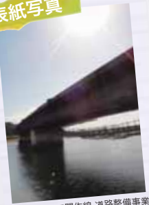
市道岩鼻中野開作線 道路整備事業 【新琴川橋(仮称)】(宇部市)
