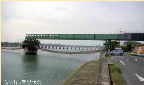
送り出し架設状況
