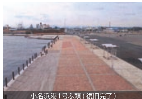
小名浜港1号ふ頭 (復旧完了)
