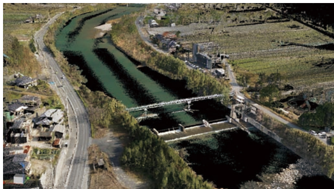
UAVレーザー測量の成果(点群データ) (二級河川島田川)
