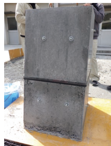
2リフト目の脱型後
