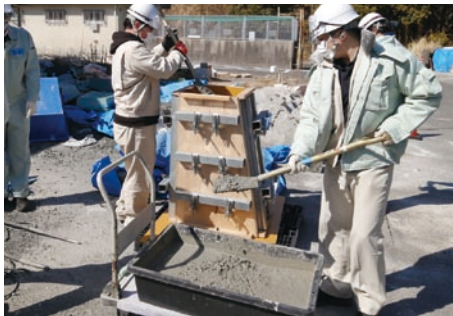
コンクリートの打設(1リフト目)
