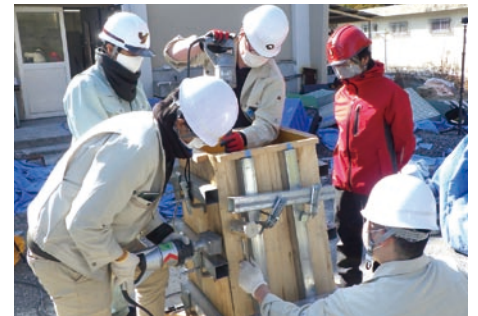
コンクリートの締固め
