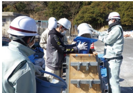
コンクリートの打設(2リフト目)
