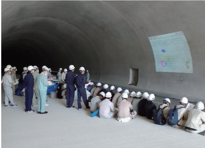
雲雀山トンネル工事、地盤改良工事概要説明
