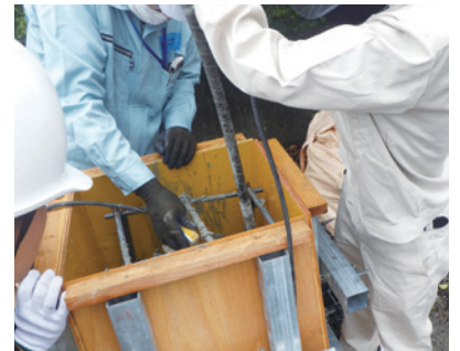
コンクリートの締固め
