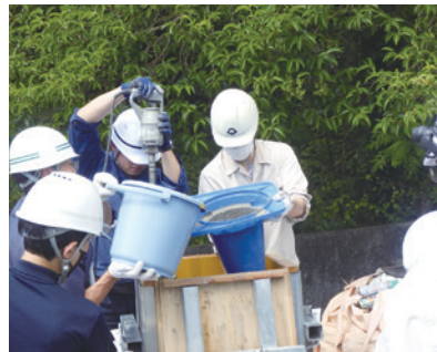
コンクリートの打設(2リフト目)
