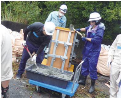
コンクリートの打設(1リフト目)
