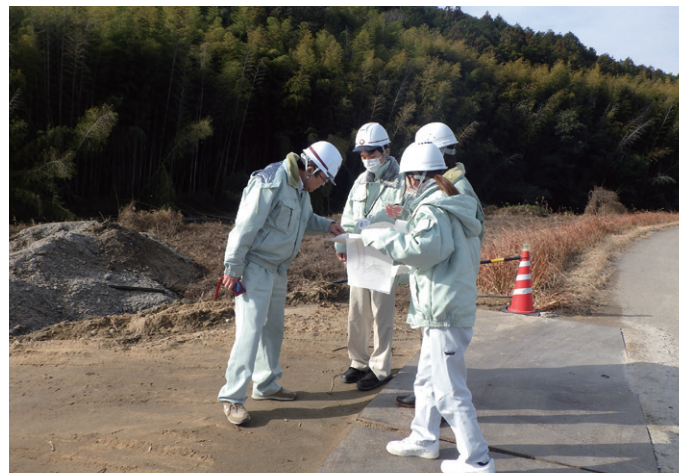
現場に着いたら、図面で施工内容を確認
