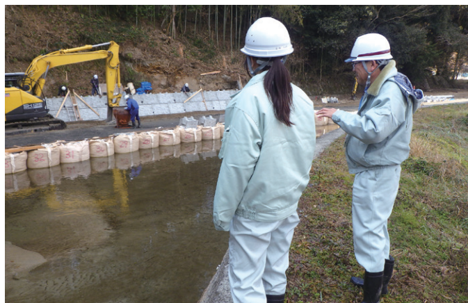
工事用道路兼締切、大型ブロック積について現場を見ながらの質疑応答
