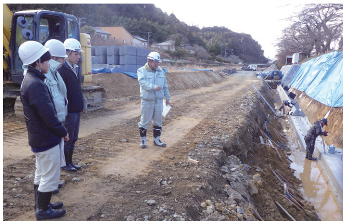
河川工事現場の状況把握と意見交換
